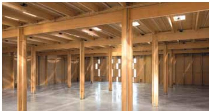
Holzbauweise: CO<sub>2</sub>-arm, nach der Nutzung mit Akkuschrauber zerlegbar.
