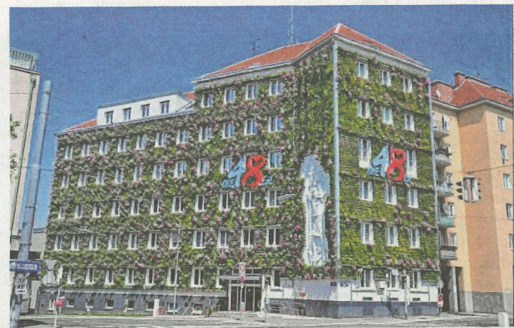
Die MA48 in Margareten gilt als Vorzeigeobjekt für Grünfassaden
