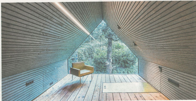
Einem alten Schuppen im Wienerwald wurde mit etwas Dämmung neues Leben eingehaucht. Die Belüftung erfolgt durch eingebaute Klappenfenster
