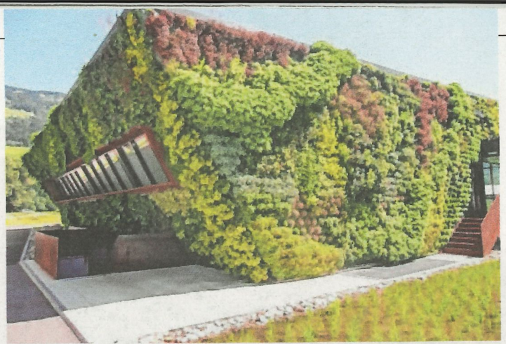
Durst-AG-Projekt in Lienz ist eines der ersten mit Living Walls in Österreich
